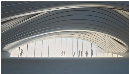
(Doppelt-gekrümmte Dachkonstruktion aus Sandwichelementen - KGBauko)
