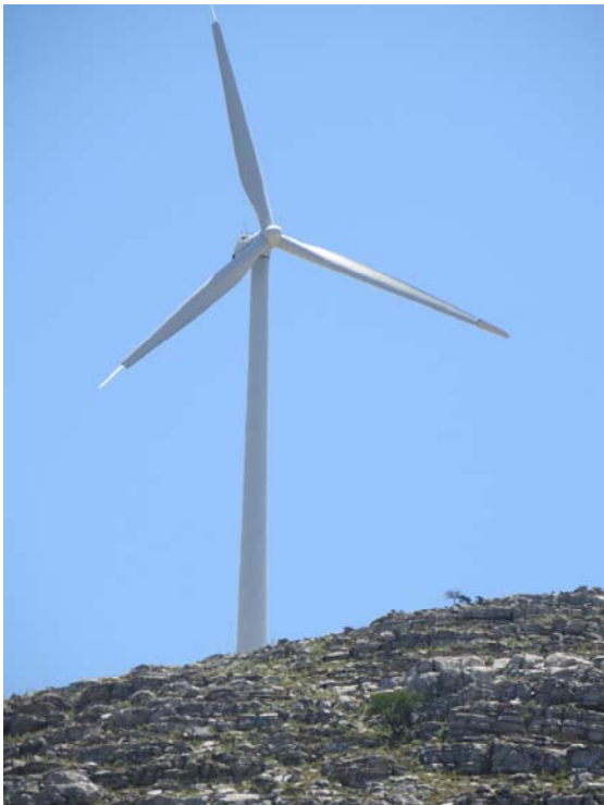
Bild: Beispiel Windkraftanlage, IPBU-Projekt 2014/15
